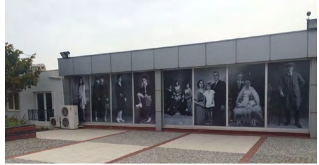
Fotoğraf 48: Yan cepheden müze binası.
