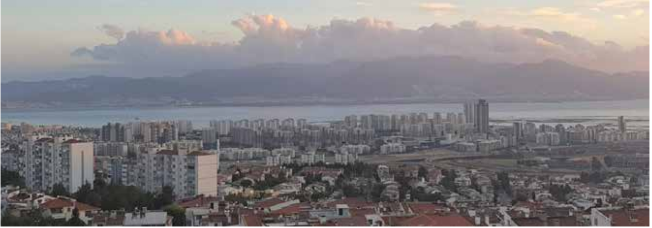
FOTOĞRAF 2.1.1. Mavişehir bölgesinin görünümü (Proje saha çalışmaları, 2022)
